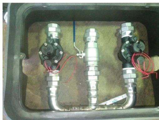
*Anstelle der hydraulischen Steuerung kommen auf dem Platz der Republik nun neue moderne Magnetventile zum Einsatz.*
