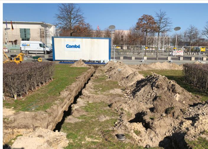
*Insgesamt wurden auf dem Gelände 1000 m neue Rohrleitungen und nochmal 1000 m neue Steuerkabel verlegt.*
