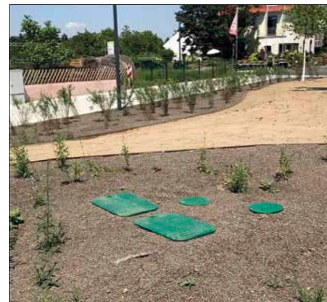
Installation eines modernen TORO Bewässerungssystems
