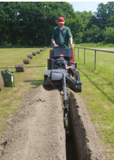
Mit der Toro Grabenfräse wird ein Rohrleitungsgraben ausgehoben
