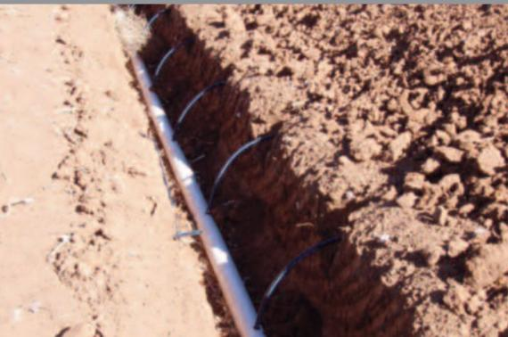
Las conexiones Xpando Take-Off son una de las mejores alternativas para conectar tuberías de riego de baja presión y líneas de riego por goteo a las tuberías principales de polietileno y PVC. Las conexiones Xpando Take-Off y los Sellos de Refuerzo Top Hat se venden en un amplio rango de dimensiones para satisfacer las necesidades de conexión de cada sistema de Microrriego.
